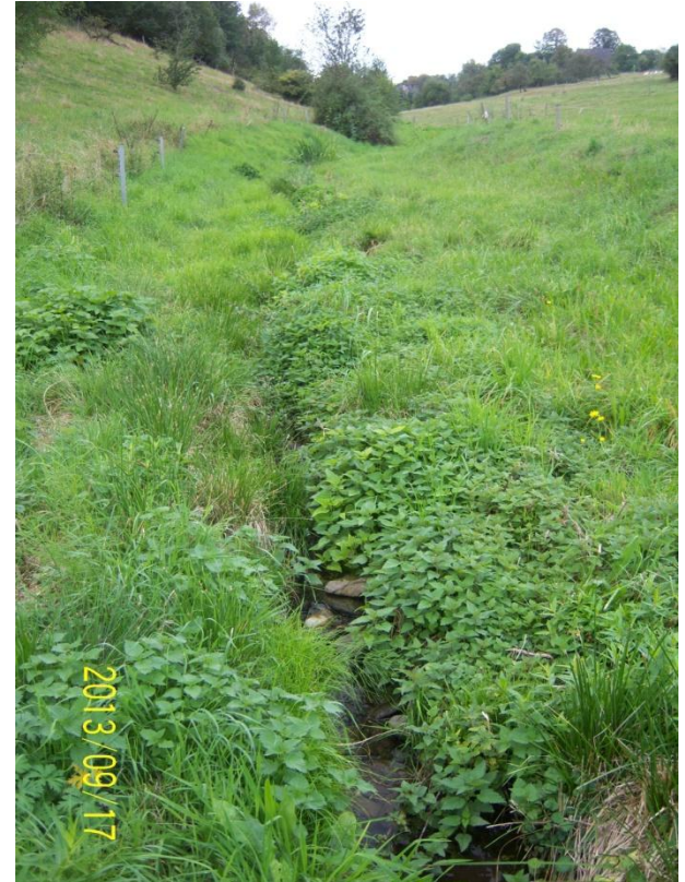
ohne Schäden im Hochwasser 2013
